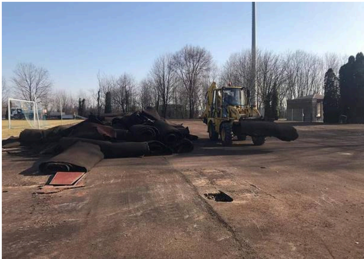
L'inizio dei lavori al campo sportivo
