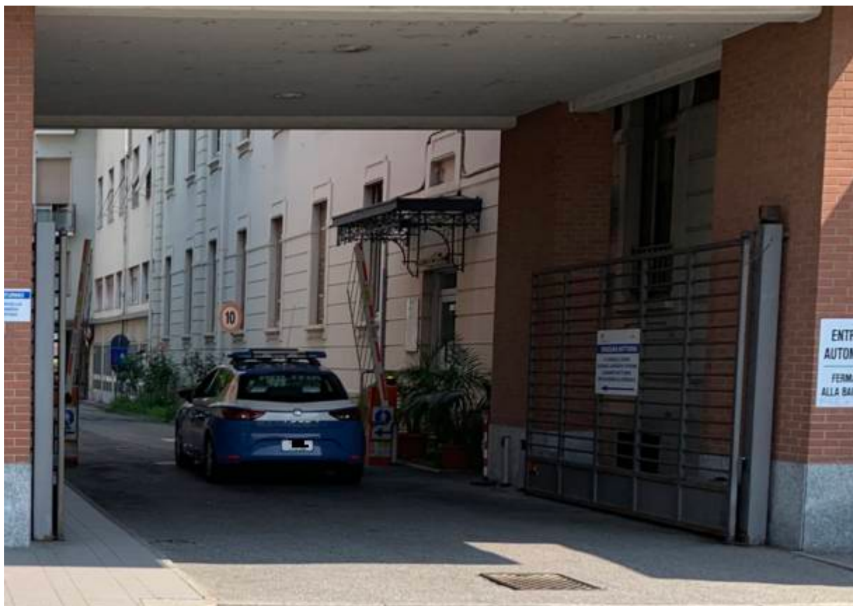
un vetro danneggiato all'interno del Pronto Soccorso
