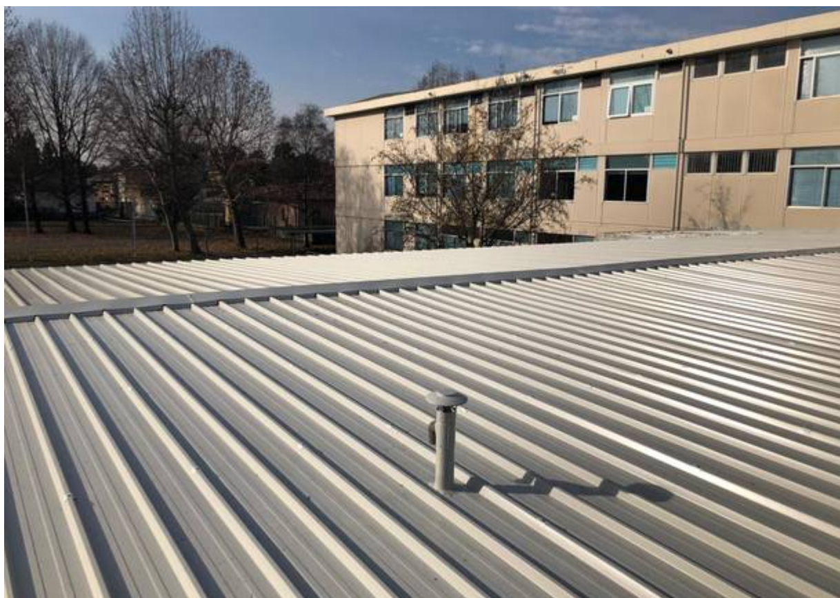
Il tetto, risistemato, delle scuole di via Luigi Galvani
