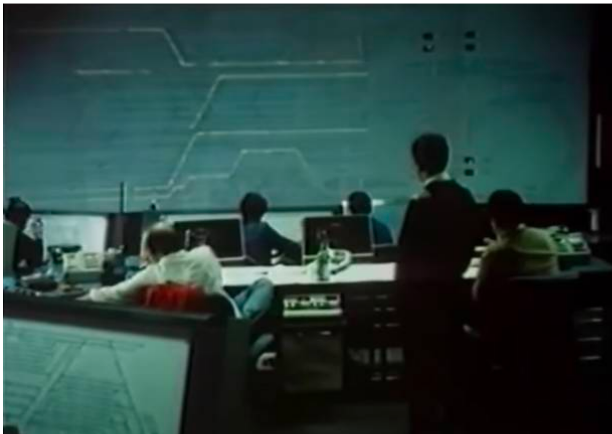
La sala operativa principale nel 1984
