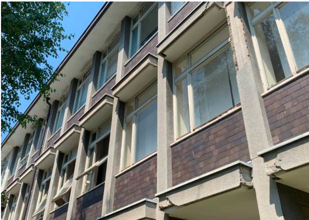
Gli ambulatori di via Fuser, oggetto di intervento di riqualificazione
