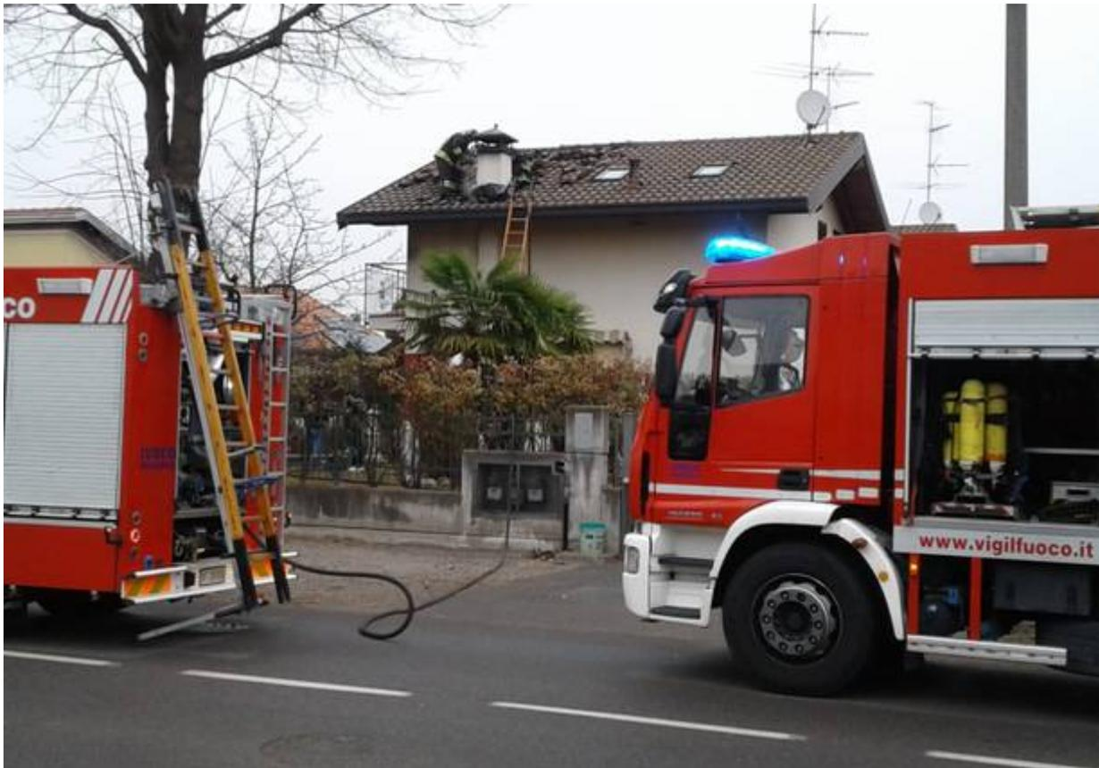
Si tratta di una dinamica piuttosto diffusa: con le temperature fredde l'utilizzo persistente di camino o riscaldamento può surriscaldare la canna fumaria, causando poi l'incendio della copertura dell'edificio (legno o materiali coibentanti).
