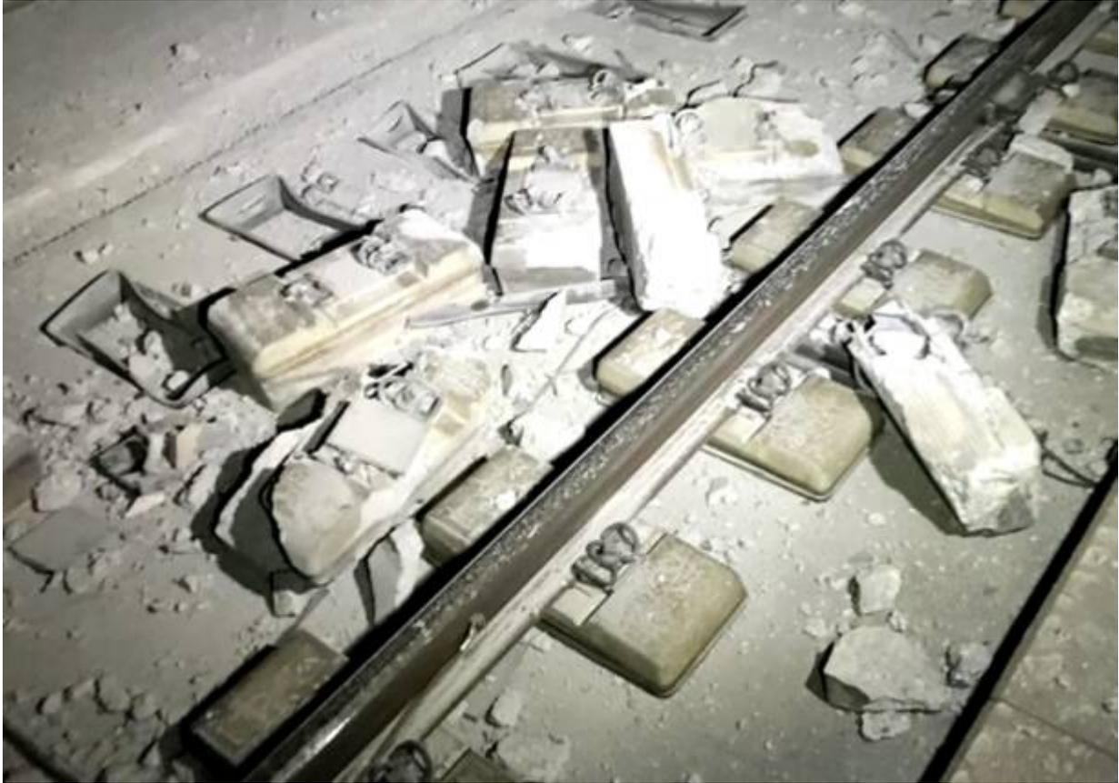
Il deragliamento nella canna Ovest del tunnel del Gottardo ha provocato il danneggiamento di 8 km di rotaie e 20mila traversine in cemento
