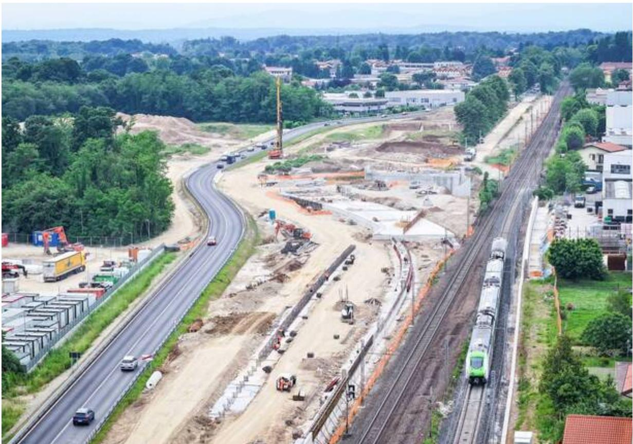
**Partendo dalla stazione Malpensa T2, sono in fase di realizzazione le strutture di copertura della galleria artificiale 06, lunga 310 metri.** Nel corso di questa settimana inizia, dall'imbocco lato sud, la **costruzione delle strutture ad arco della successiva galleria naturale, lunga 385 metri.**
