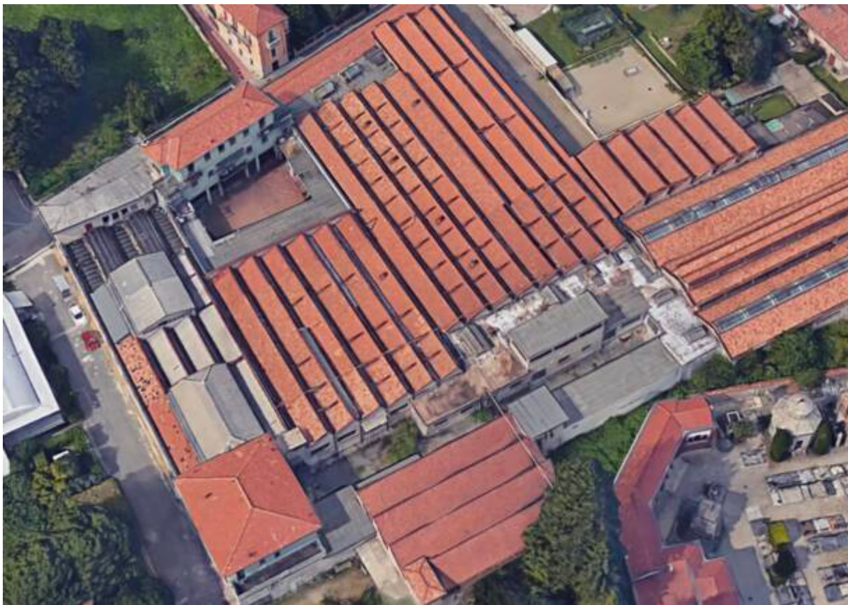
Il complesso della fabbrica tessile dismessa tra via Briante e via Rimembranze
