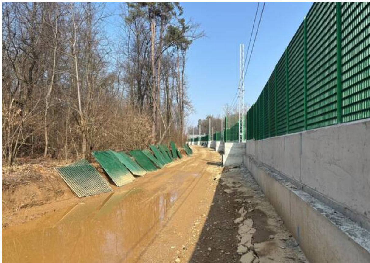
La strada di cantiere, marzo 2026
