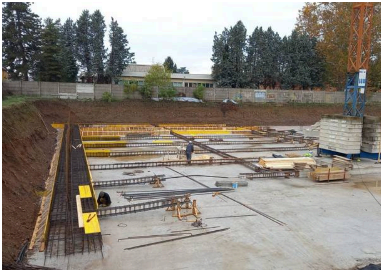
Palestra in costruzione su terreno vergine tra Samarate e la frazione Verghera
