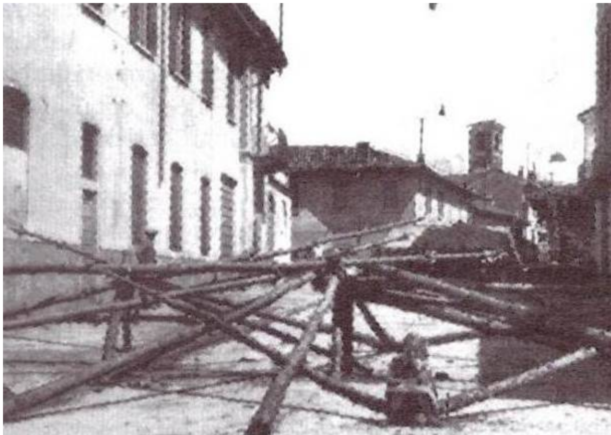
Barricate allestite al ponte di via Novara, per impedire l'accesso alla città. Dal libro "Figure nel vento" di Pier Giuseppe Siron
